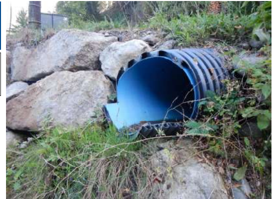
Trop plein de l'ouvrage de prise Diam 400
