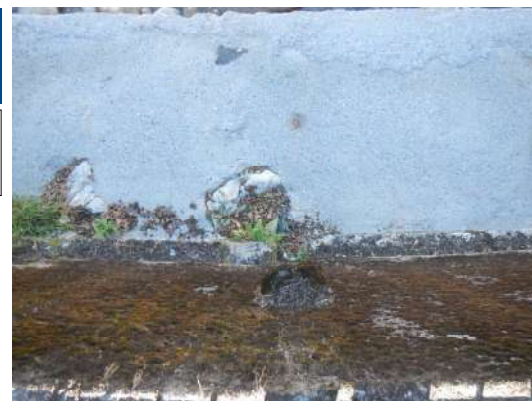
Buse de rejet
