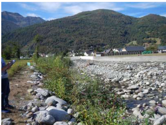
Végétation dense dans le talus en enrochements (Buddleia)
