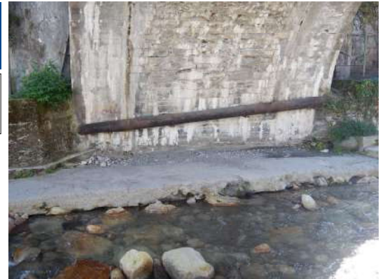
Conduite métallique sur la culée du pont de Soulom (dans le lit mineur)
