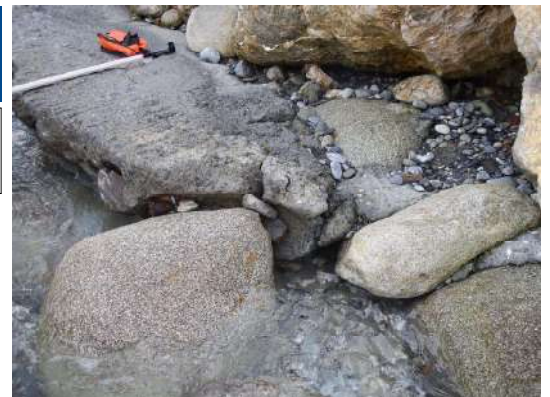
Semelle béton manquante + suspicion de soulèvement de la semelle en aval
