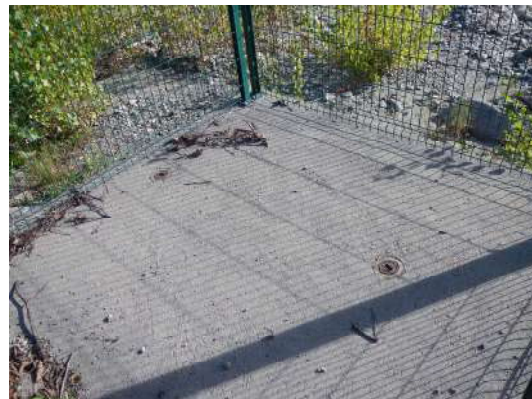
Piezomètres sur plateforme béton dans le talus
