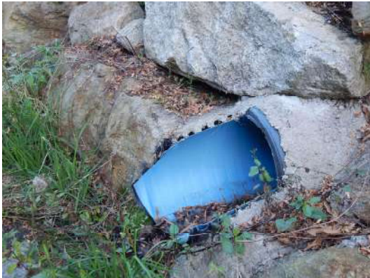
Trop plein de l'ouvrage de prise Diam 400
