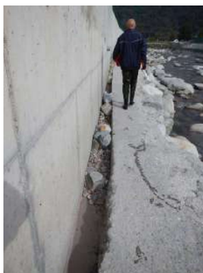
Rainure entre la semelle et le mur béton
