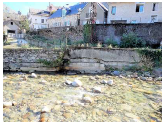
Buse de rejet + Fissure du mur béton + végétation en crête
