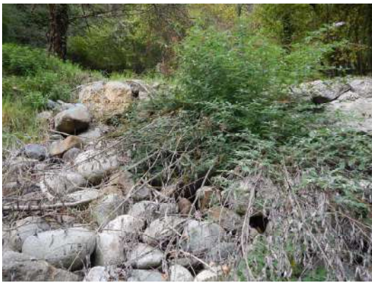
Végétation dans le talus à la transition GC 29.1 et GC 29.2
