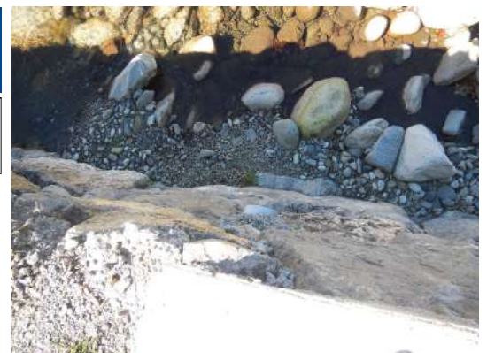
Buse rejet EP
