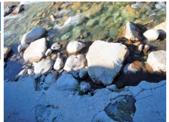
Blocs de carrière en protection de la semelle RD (extrados)
