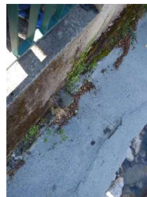
Buse de rejet
