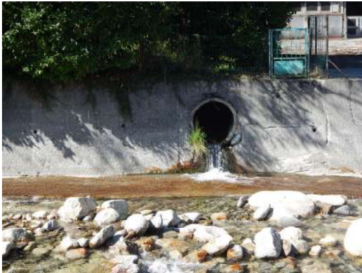
Rejet diam 800 (+ photo DSCN0636.JPG)
