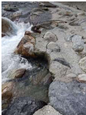
Destructuration du seuil E
