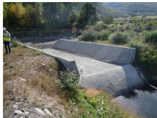
Seuil déversant béton
