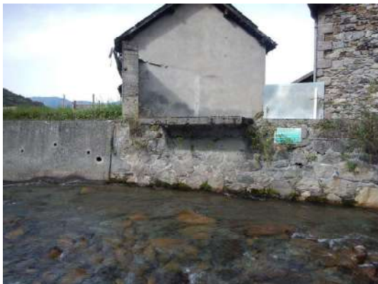
Plateforme béton (utilité ?)
