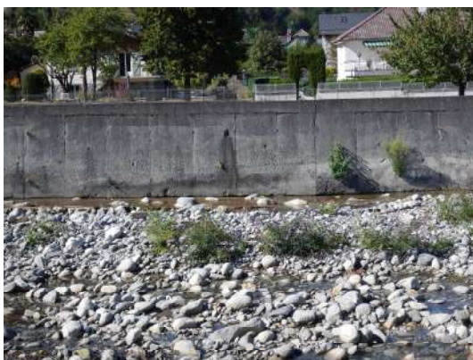
Buse rejet EP
