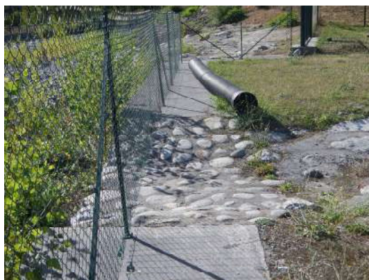
Déversoir en enrochements bétonnés
