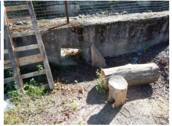
Ouverture 15x60cm en tête de mur de soutènement
