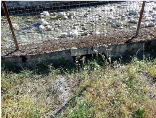
Ouverture 10x60cm en tête de mur de soutènement
