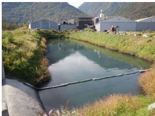
Bassin de sortie des eaux de refroidissement
