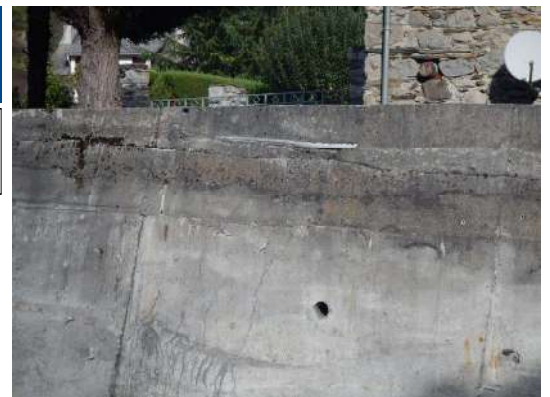
Canalisation visible dans le réhaussement du mur béton
