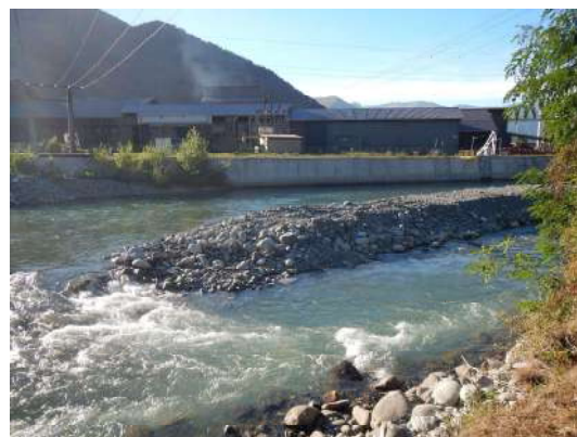
Atterrissement central aménagé
