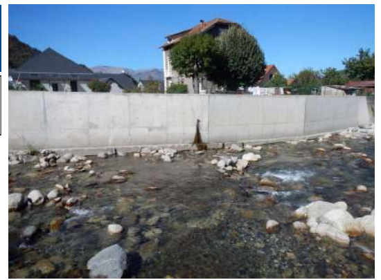
Buse rejet EP
