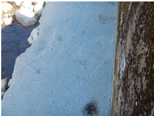
Buse de rejet du lavoir
