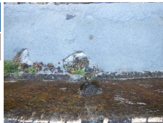
Buse de rejet
