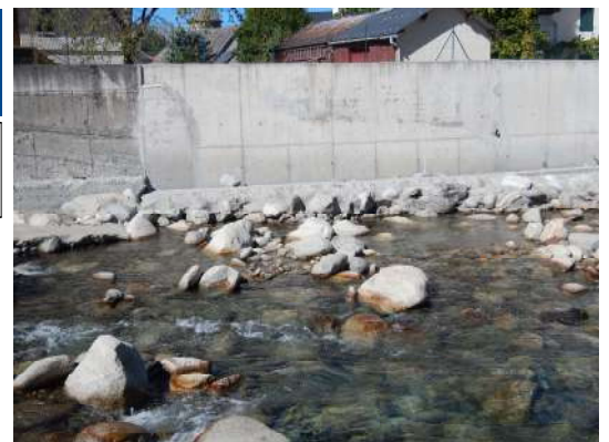
Désolidarisation des enrochement de la semelle sur 10m env
