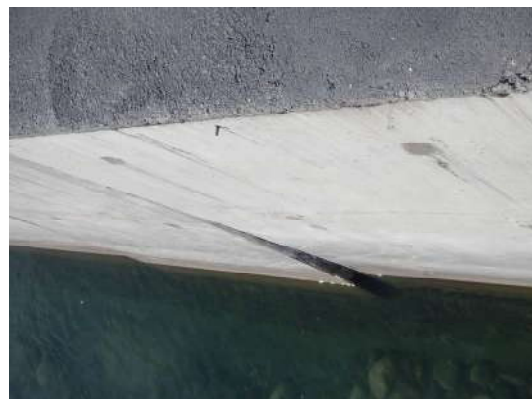
Dalles préfabriquées décalées
