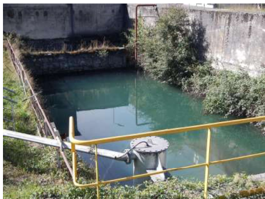
Bassin de décantation de la prise d'eau FERROPEM
