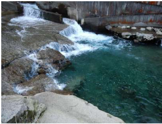
Fosse d'érosion en pied de seuil
