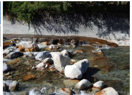
Semelle béton en limite d'affouillement
