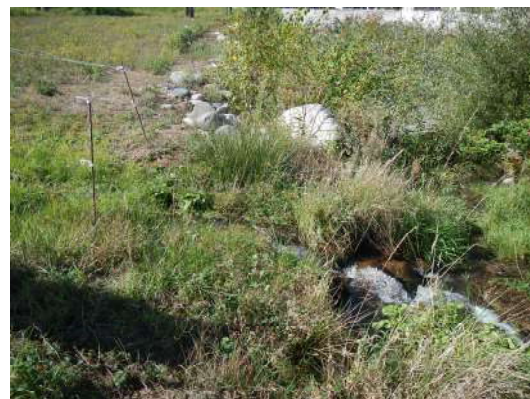
Rejet de fossé en rive droite
