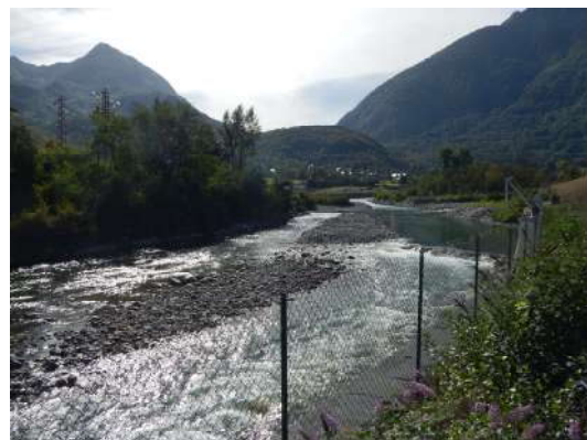
Atterrissement aménagé en milieu de lit pour maintien du niveau d'eau
